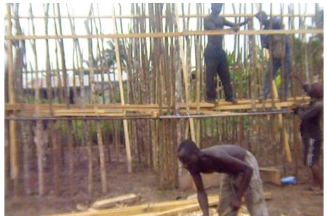
Image n° 2 : Perches fichées verticalement
