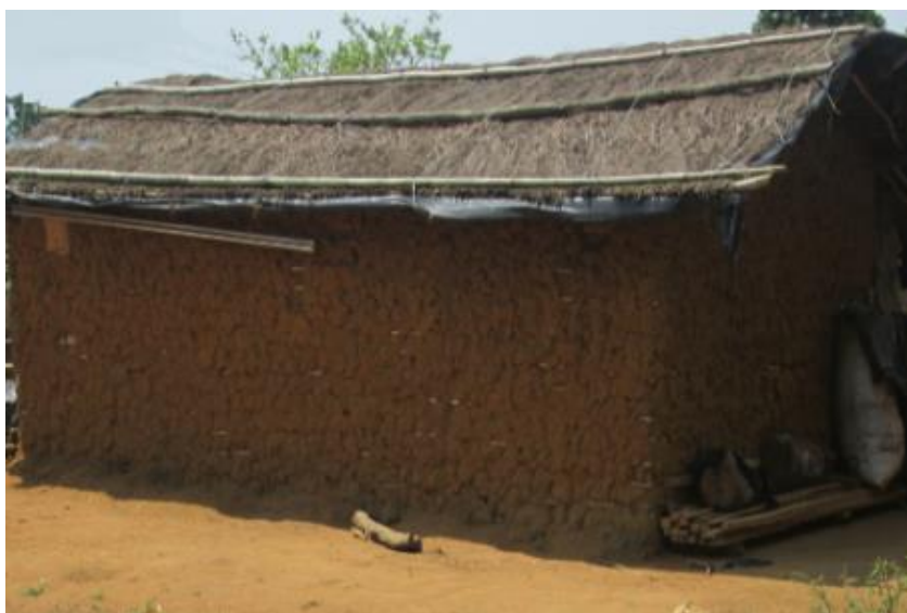
Image n° 7 : Armature enrobée de banco
