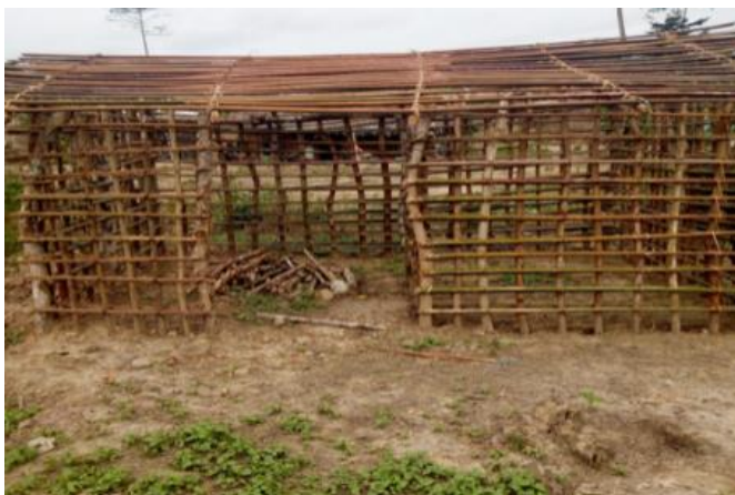
Image n° 3 : Réseau de bambous reliés à des poteaux constitués de bois
